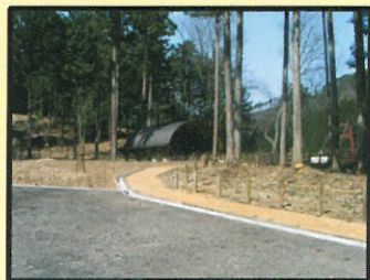
駐車場から広場・吊り橋
