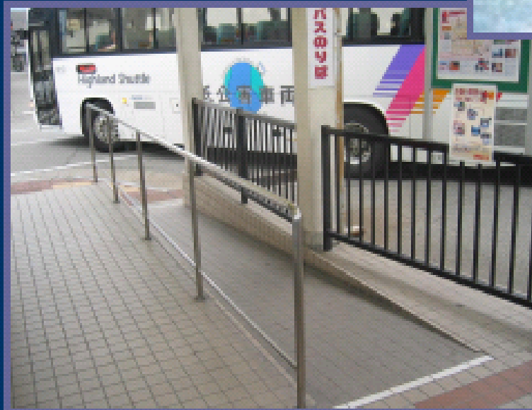
バスセンタースロープ設置
