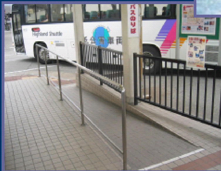
バスセンタースロープ設置
