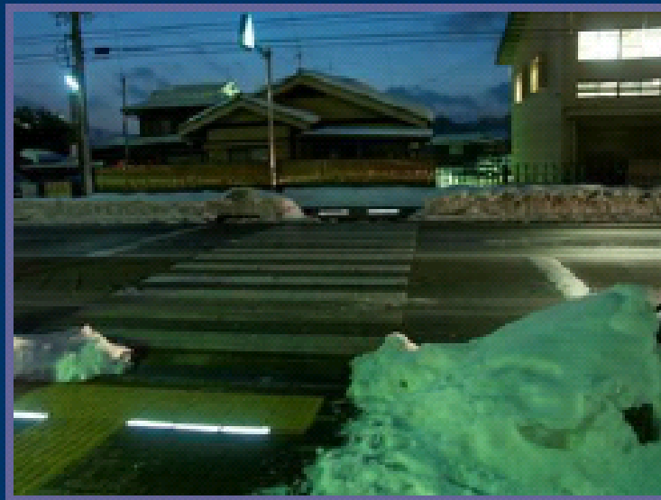
誘導ブロック融雪システム・光による知らせるあかりシステム(市役所前)
