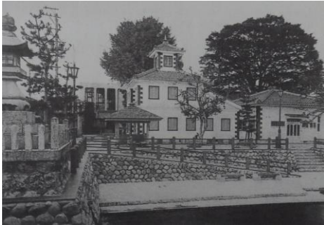
上：明治末期の赤坂湊 下：赤坂湊跡に建つ赤坂港会館
