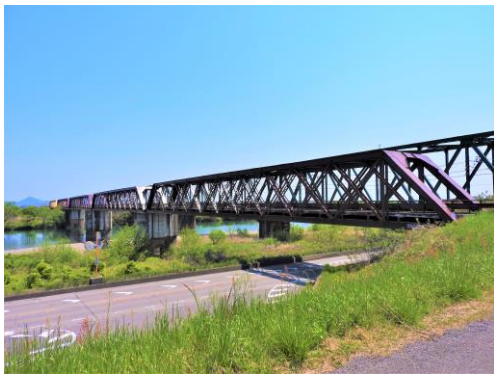
【揖斐川橋】 錬鉄製ダブルワーレントラス橋
