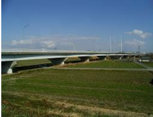
【源氏大橋】 鋼連続 I 桁橋
