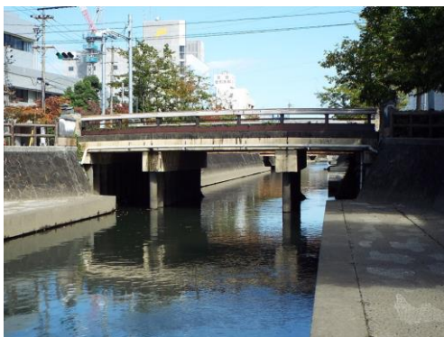
【武者留橋（丸の内 6 号橋）】 単純 RC 中実床版橋
