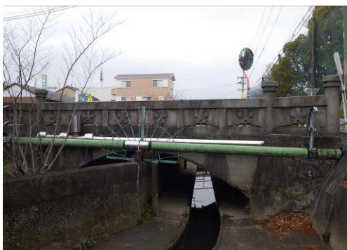
【久瀬川 5 号橋（蛸雪橋）】
