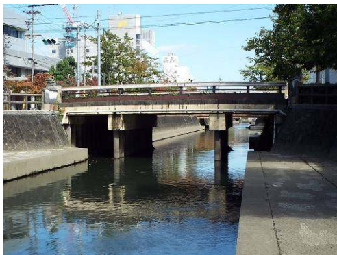
【武者留橋（丸の内 6 号橋）】 単純 RC 中実床版橋
