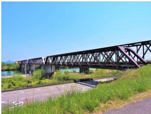
【揖斐川橋】 錬鉄製ダブルワーレントラス橋 ※揖斐川橋は、東海道本線が開通した際の鉄道橋を道路橋に転用したもので、東海道本線開通時から現位置で残る唯一の遺構である。平成 20 年に国の重要文化財に指定された。
