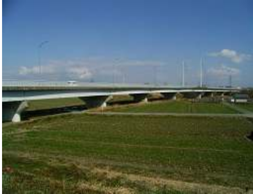
【源氏大橋】 鋼連続 I 桁橋
