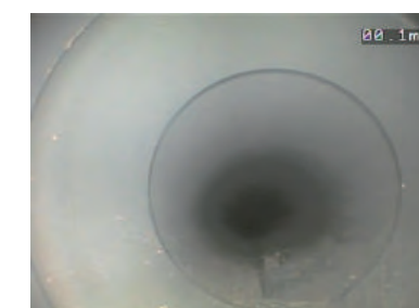
布設替した取付管(塩化ビニル管)
