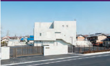
笠木ポンプ場【公共下水道事業】
