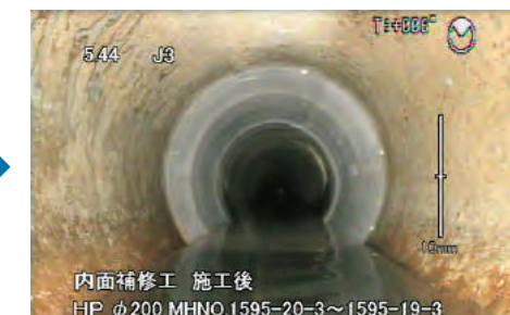
修理後の下水道管
