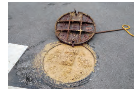
油で下水道管が詰まり、マンホール内が汚物でいっぱい!!
