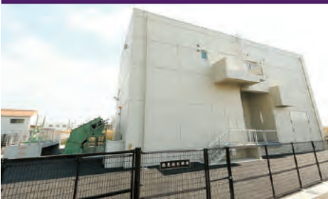
鶴見ポンプ場【公共下水道事業】
