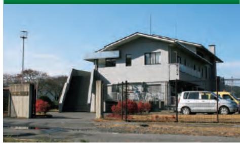
上石津北部浄化センター【特定環境保全公共下水道事業】
