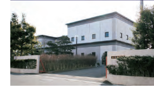
本今ポンプ場【公共下水道事業】
