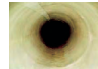
更生された下水道管
