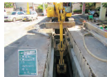
道路掘削状況
