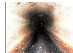
老朽化した下水道管
