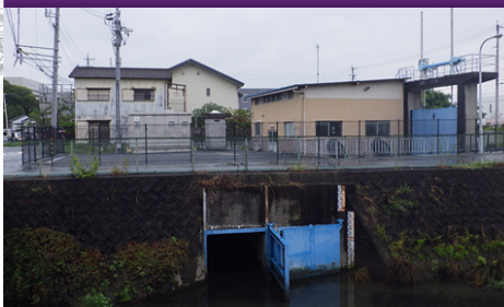
南瀬ポンプ場【公共下水道事業】
