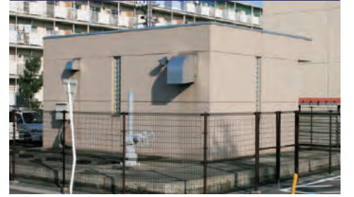
外瀬ポンプ場【公共下水道事業】
