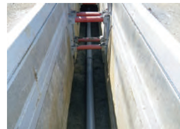
下水道管布設状況
