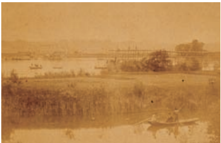
建設途中の関西鉄道揖斐川橋梁〔個人蔵〕 明治27年（1894）5月14日撮影。揖斐川東堤より全景を望む。
