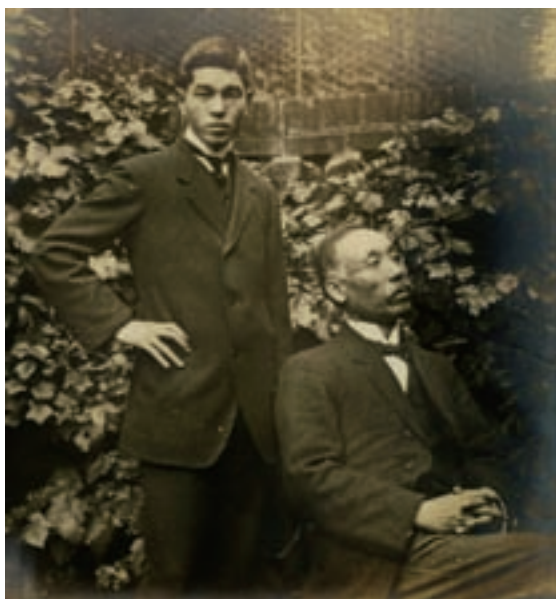
欧米各国の図書館を視察【個人蔵】 明治42年(1909)9月23日、ロンドンにて撮影。右が万吉、左は早稲田大学から派遣され、欧米を視察していた佐藤功一。佐藤は、早稲田大学に建築科を創設したことで知られる建築家。同大学のシンボルとなっている大隈講堂などを残した。
