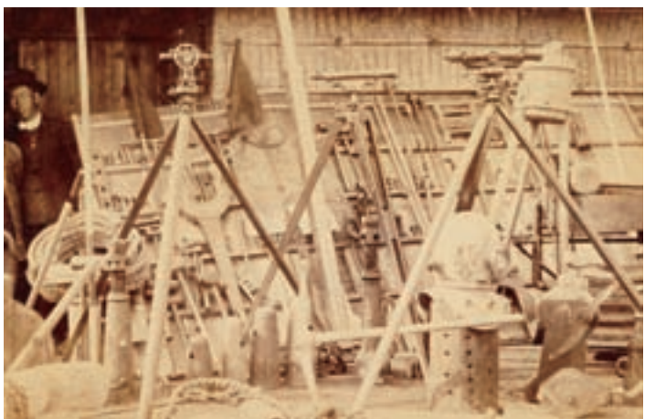
関西鉄道揖斐川橋梁の建設機材〔個人蔵〕 大型の工具、測量機、潜水道具などが見られる。
