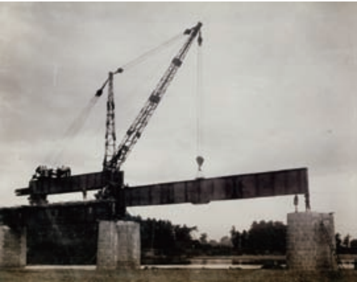
那波式デリック・クレーンによる橋梁架設〔個人蔵〕
