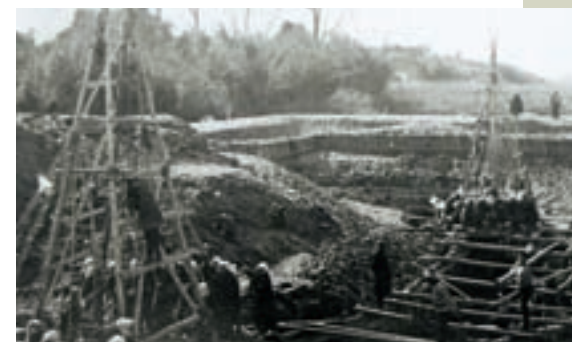
水門川の旧排水機場の工事／昭和初期
