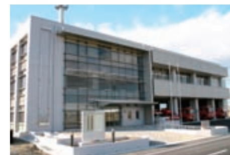
大垣消防組合消防本部の新庁舎／平成17年2月
