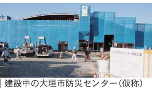
建設中の大垣市防災センター(仮称)
