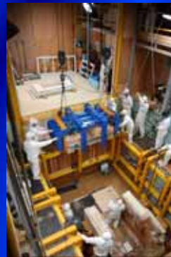
石室解体と石材取り出しの様子
