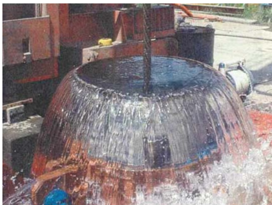
井戸さく井工事の状況
