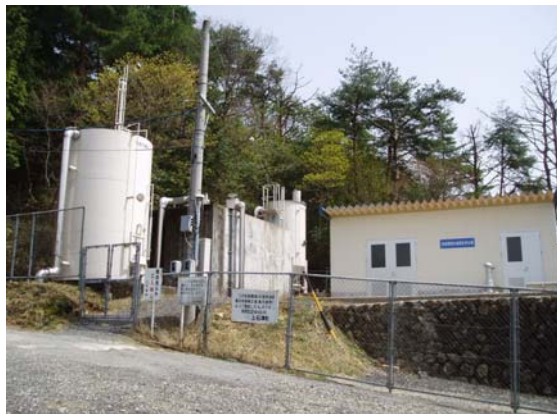
多良高区浄水場
