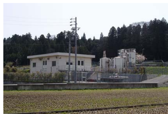
多良低区浄水場
