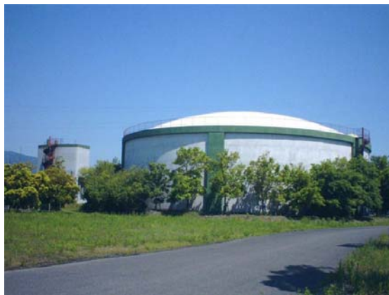
北部配水池（容量：8,100m 3 ）
