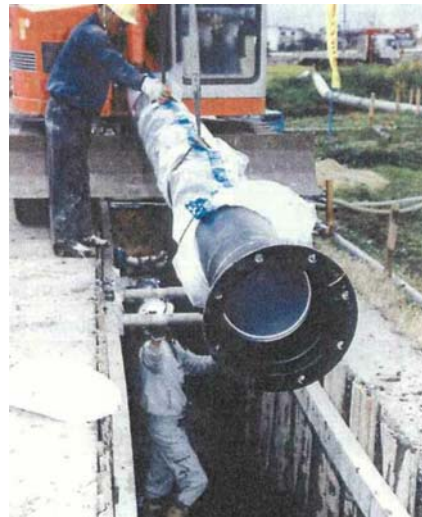
配水管（耐震）布設状況
