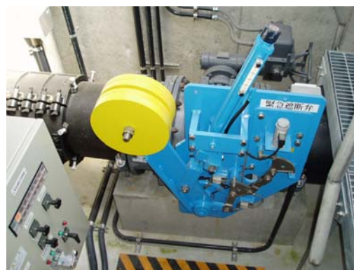
緊急遮断弁の設置状況
