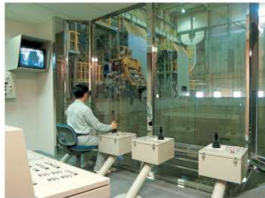
クレーン操作室
