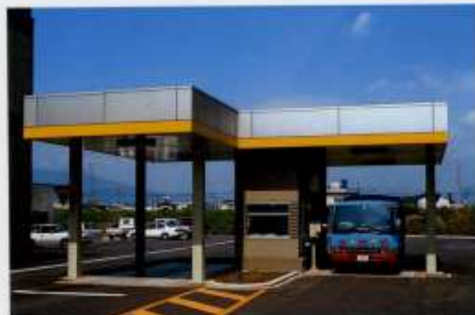
計量機：収集車で運ばれてきたごみの量を自動計量します。
