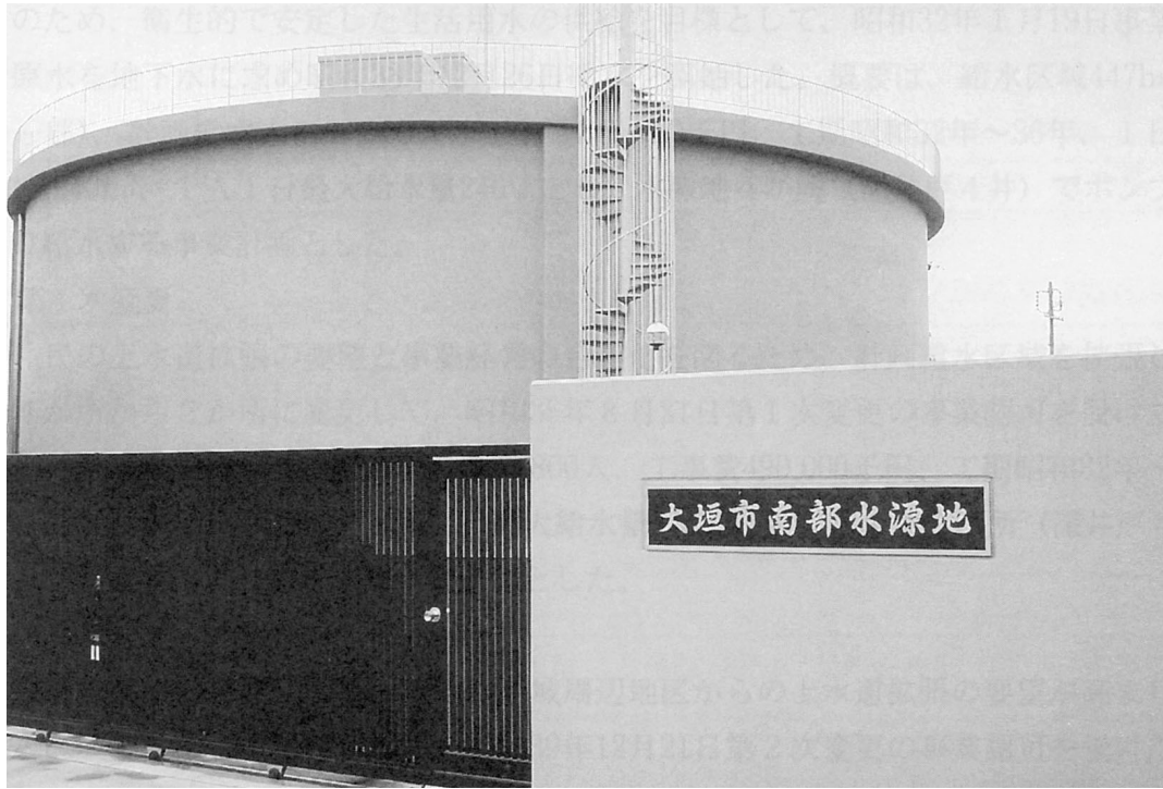
大垣市南部水源地
