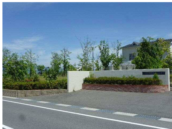
■墨俣浄化センター
