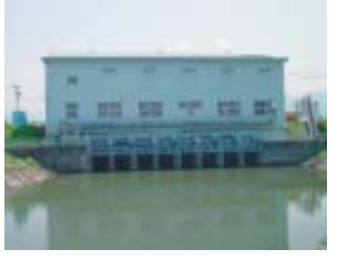
新水門川排水機場
