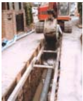
市内の下水道布設工事
