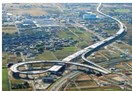
(仮称)大垣西ICから南を望む (1月撮影、岐阜国道事務所提供)
