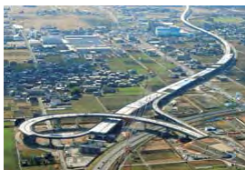
(仮称)大垣西ICから南を望む(1月撮影、岐阜国道事務所提供)
