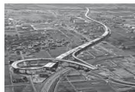
大垣西IC(仮称)から南を望む
