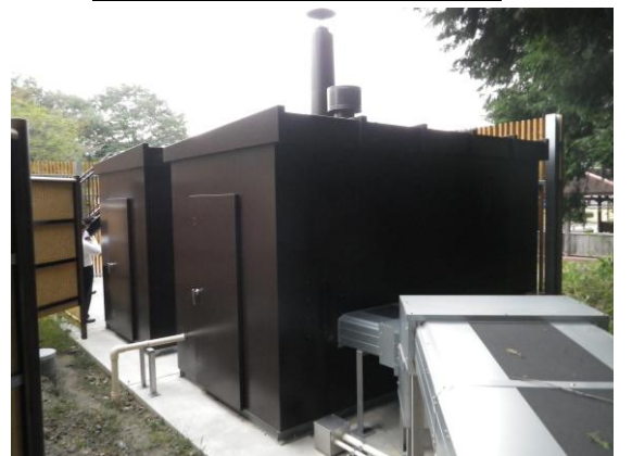
ペレットボイラー(奥養老)
