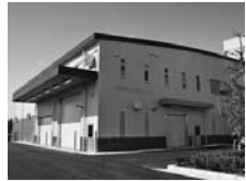
稼働したリサイクルセンター
