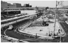
9月に完成予定の大垣駅北口広場
