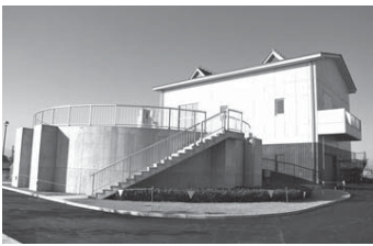
まもなく完成する墨俣浄化センター
