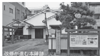
改修が進む本陣跡
