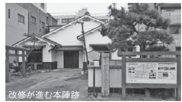
改修が進む本陣跡
