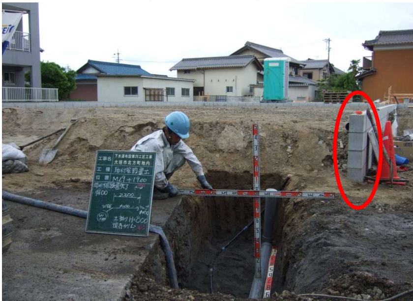
①全景図(構造物などの位置から取付管の位置がわかる写真)
