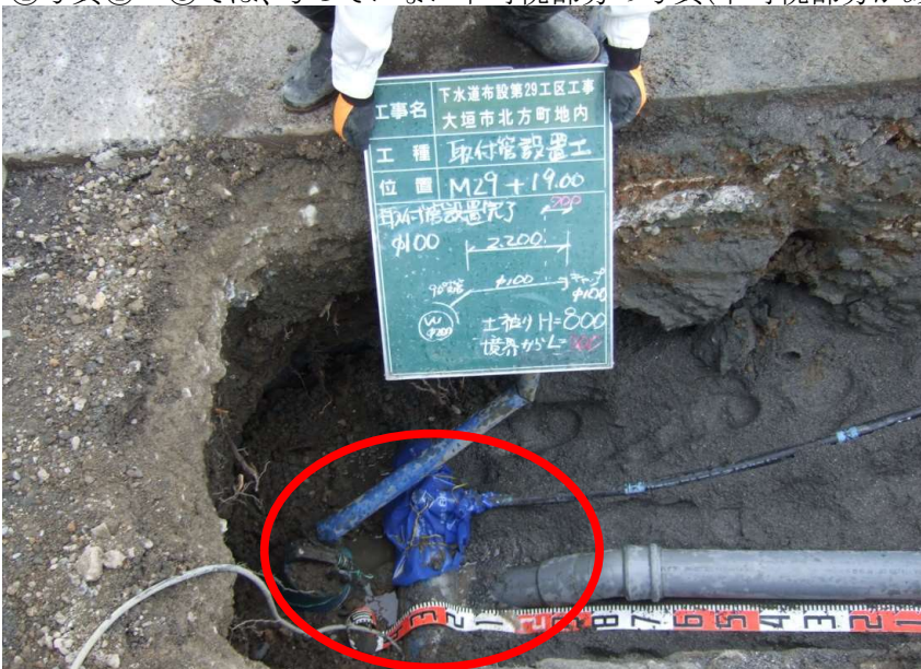
④写真①～③では、写っていない不可視部分の写真(不可視部分がある場合のみ)
