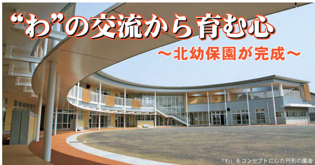
「わ」をコンセプトにした円形の園舎
