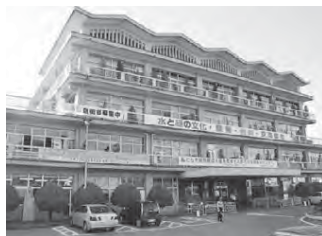
建て替えが予定されている市役所本庁舎
