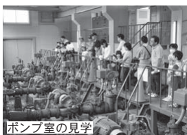
ポンプ室の見学
