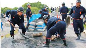
△土のうを積み上げ、堤防の嵩上げを図る「積土のう工(天端)」
