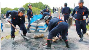
△土のうを積み上げ、堤防の嵩上げを図る「積土のう工(天端)」
