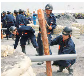
△土のうを積み上げ、堤防の嵩上げを図る「積土のう工(天端)」
