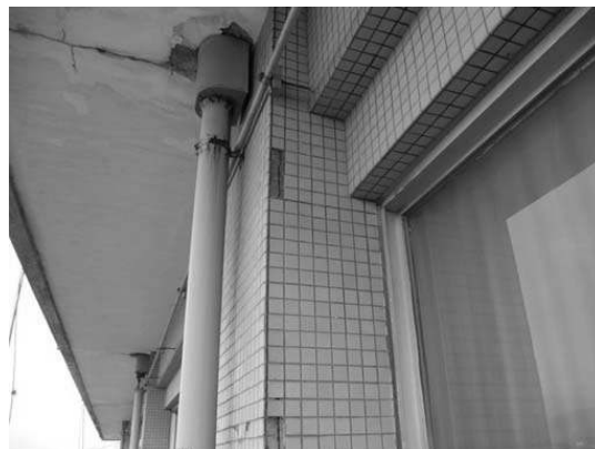
剥離したタイル
