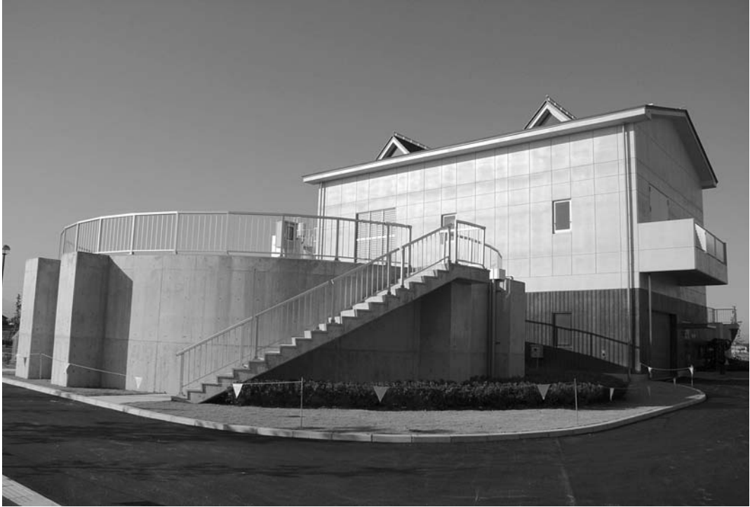
墨俣浄化センター
