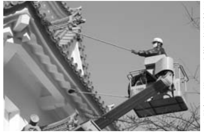
高所作業車で屋根のちりを落とす作業員
