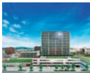
平成28年9月末完成予定の大垣駅南街区再開発ビル
