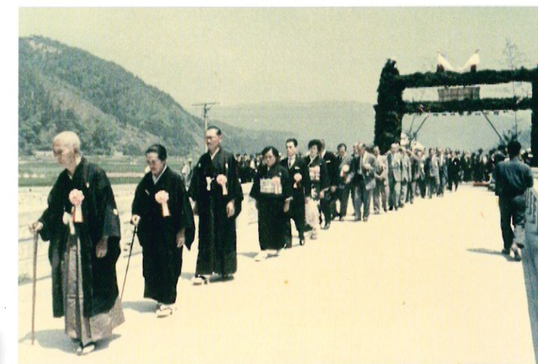
一之瀬橋渡り初め(昭和36年5月1日)
