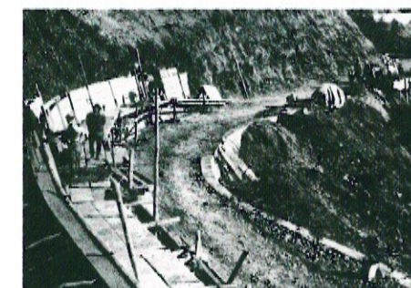
大洞林道の建設工事がはじまる (昭和38年7月5日)
