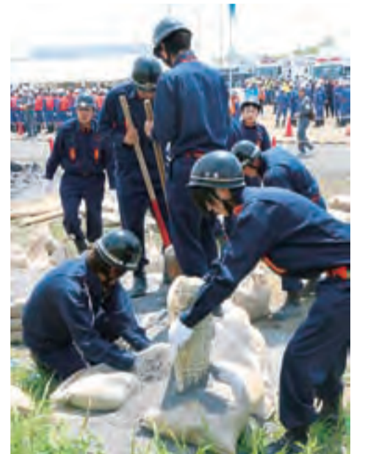
手際よく土のうを積み固める団員(月の輪工)
