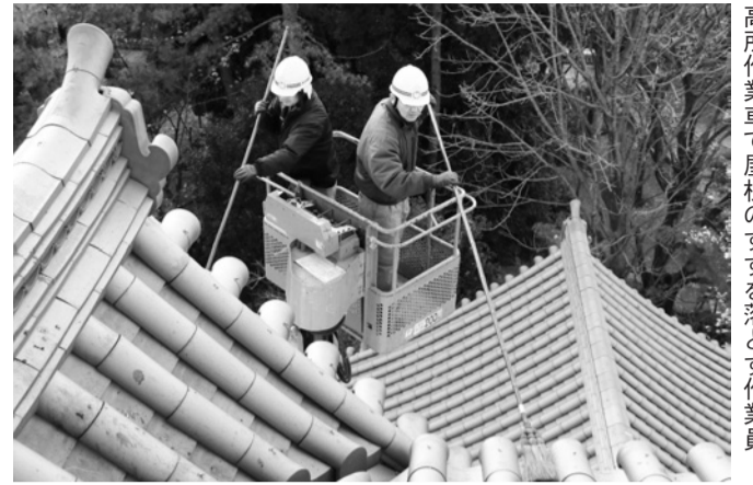
高所作業車で屋根のすすを落とす作業員
