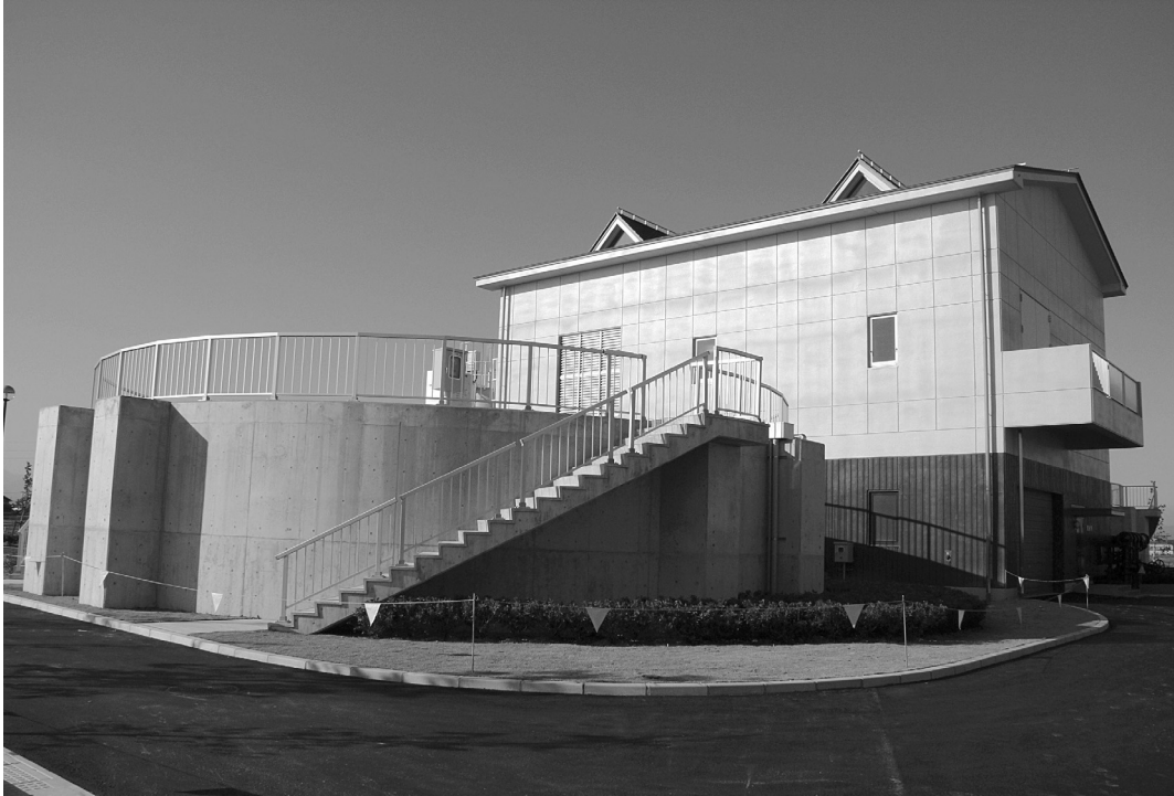
墨俣浄化センター
