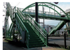
●久瀬川町の歩道橋(久瀬川町)
