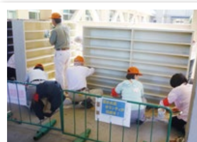
下駄箱の修理・ペンキ塗り
