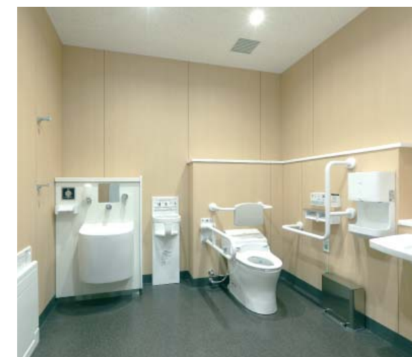
多目的トイレの例（愛西市）
