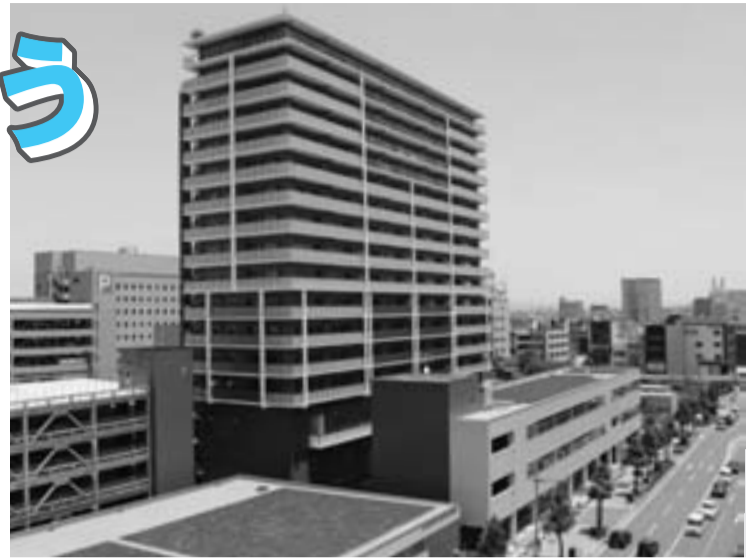
まちなか子育て支援施設「キッズピアおおがき」が入っているスイトアベニュー（大垣駅南街区再開発ビル北棟）。
