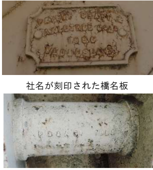
ピン鞘管の刻印（PS&A Co）
