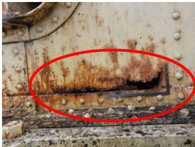
腐食による断面欠損
