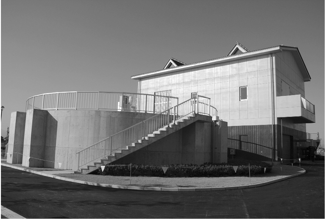
墨俣浄化センター
