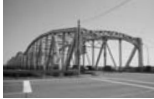
▲景観遺産22: 揖斐大橋
