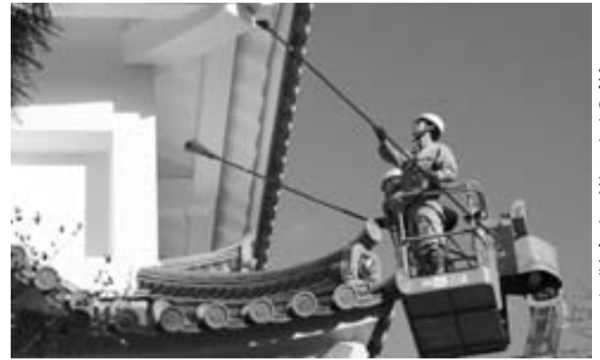
屋根のすすを落とす作業員
