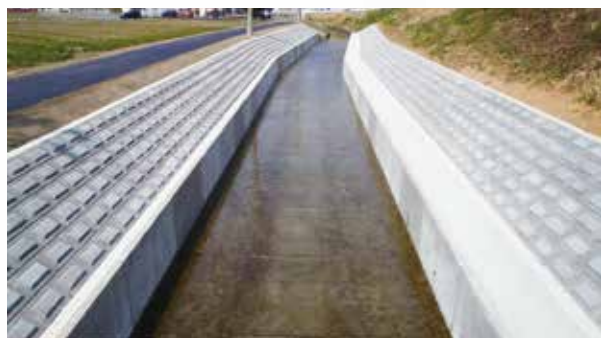
整備された排水路「北方 1号幹線排水路」
