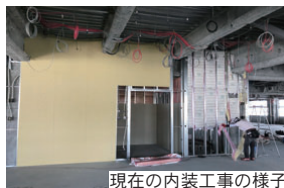
現在の内装工事の様子
