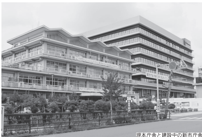
現本庁舎と建設中の新市庁舎
